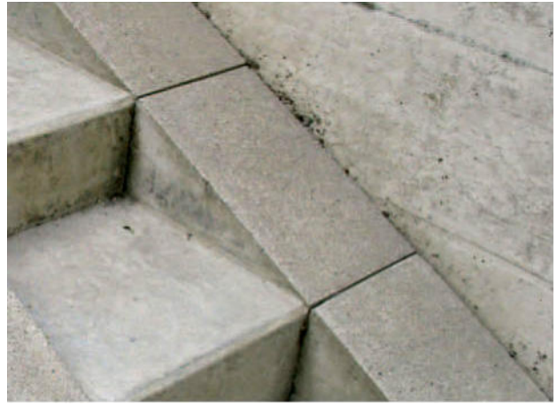
Abb. 11 Rampe am Treppenrand
