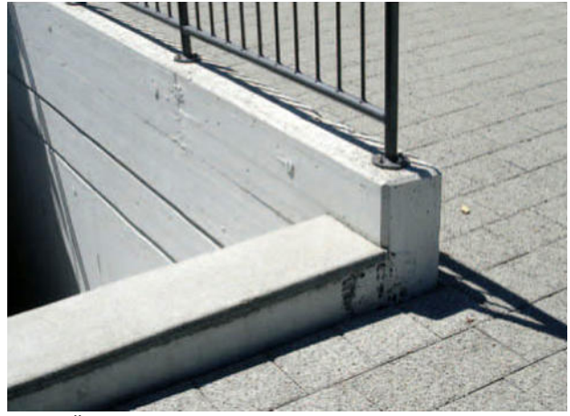
Abb. 9 Überhöhter Rand um Treppenabgang
