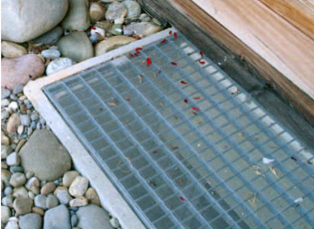
Abb. 12 Mit feinem Gitter bespannter Lichtschacht
