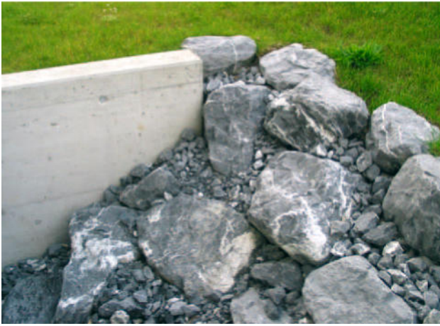
Abb. 8 Mit Steinen ausgebildeter Lichtschacht
