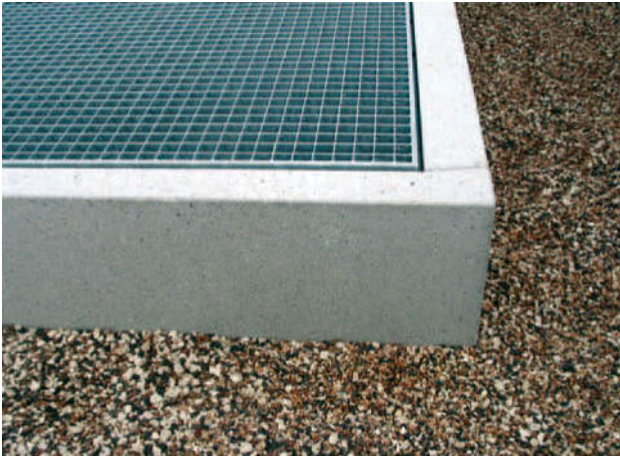
Abb. 10 Überhöhter Schachtrand
